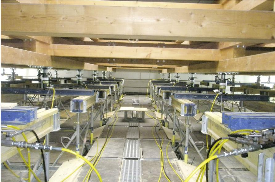
Mit Hydraulikpressen wurde das Hallendach Stück für Stück angehoben und sogar überhöht.
