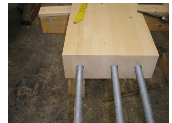
Bild 11: Einführen der Stahlstäbe in die vorbereiteten Bohrlöcher (Fa. Grossmann)
