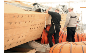
Bild 18: Bohrlocher für die Stahlstäbe (Fa. Schaffitzel)
