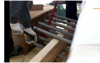
Bild 19: Entlüftungslöcher (Fa. Schaffitzel)
