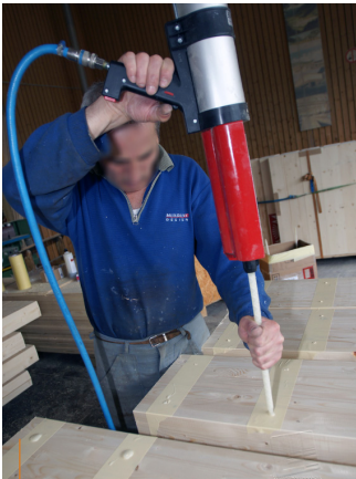
Bild 15: Einfüllen des Klebstoffes über zusätzliche Bohrlocher, ersichtlich ist auch das Austreten des Klebstoffes aus den Bohrlochern (Fa. Mayr-Melnhof Kaufmann Reuthe GmbH)
