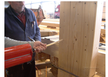
Bild 10: seitliche Bohrlöcher zum Einfüllen des Klebstoffes (Fa. Derix)
