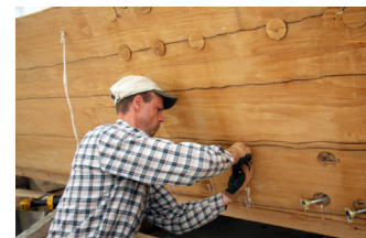
Bild 22: Zwei eingebrachte Hohlbohrer mit der Schlauchkupplung (Fa. Schaffitzel)
