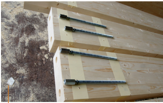
Bild 14: seitliche Bohr-löcher zum Einfüllen des Klebstoffes, ersichtlich sind auch die vorbereiteten Bohrlöcher für die Stahlstäbe und die zu verwendenden Stahlstäbe (Fa. Mayr-Melnhof Kaufmann Reuthe GmbH)
