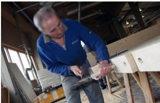
Bild 16: Positionierung des Stahlstabes in dem vorbereiteten Bohrloch (Fa. Mayr-Melnhof Kaufmann Reuthe GmbH)
