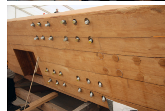
Bild 21: fast vollständig eingeführte Stahlstäbe (Fa. Schaffitzel)
