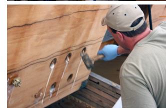
Bild 24: Verschließen der Löcher für den Hohlbohrer mit Holzdübeln (Fa. Schaffitzel)
