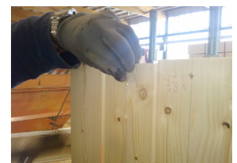
Bild 13: Austreten des Klebstoffes aus dem obersten Loch und Verschließen des Lochs mit Kunststoffdübeln (Fa. Derix)
