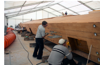
Bild 20: Zentrisches Einführen von Stahlstäben (Fa. Schaffitzel)
