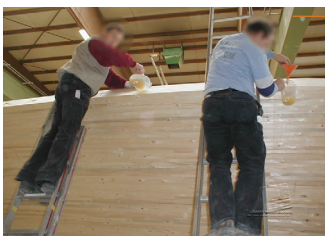
Bild 8: Einfüllen des Klebstoffes in die Bohrlöcher (Fa. Gröber)
