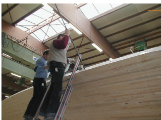
Bild 9: Einführen eines Stahlstabes in das Bohrloch (Fa. Gröber)
