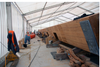
Bild 17: Blockverkleb-ter Brett-schichtholzträger für die Brücke Sneek, NL, Randträger (Fa. Schaffitzel)
